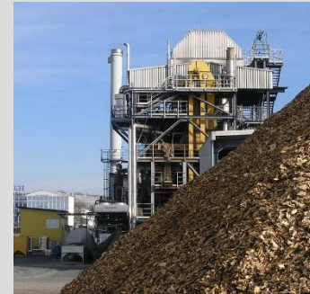
Biomassekraftwerk in Güssing
